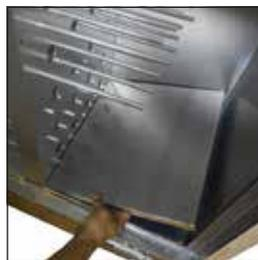
**A3.** Verkleidung aus Aluminiumpanel entfernen.
